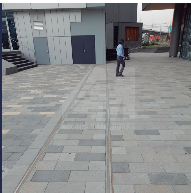
Tapajuntas para Juntas de Dilatación Sísmica tipo Bandeja
